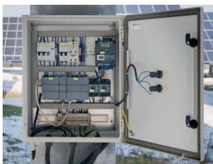
**Oben:** Überlagerter Leitreechner für den gesamten Solarpark ist ein Simatic Industrie-PC IPC 427C, der via Ethernet die Tracker-Steuerungen reihum abfragt und deren Betriebsdaten visualisiert. Links: Herzstück jedes Trackers ist eine daran installierte speicherprogrammierbare Steuerung Simatic S7-1200 von Siemens, die über einen astronomischen Algorithmus aus der Solar Tracking Toolbox die Lage zur Sonne berechnet und das System nachführt.
